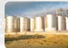
Paslanmaz Tank&Silo İmalat ve Montajı
