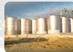
Paslanmaz Tank&Silo İmalat ve Montajı
